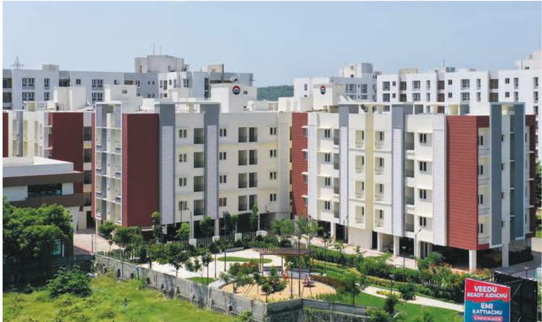
ACTUAL SITE PHOTO
