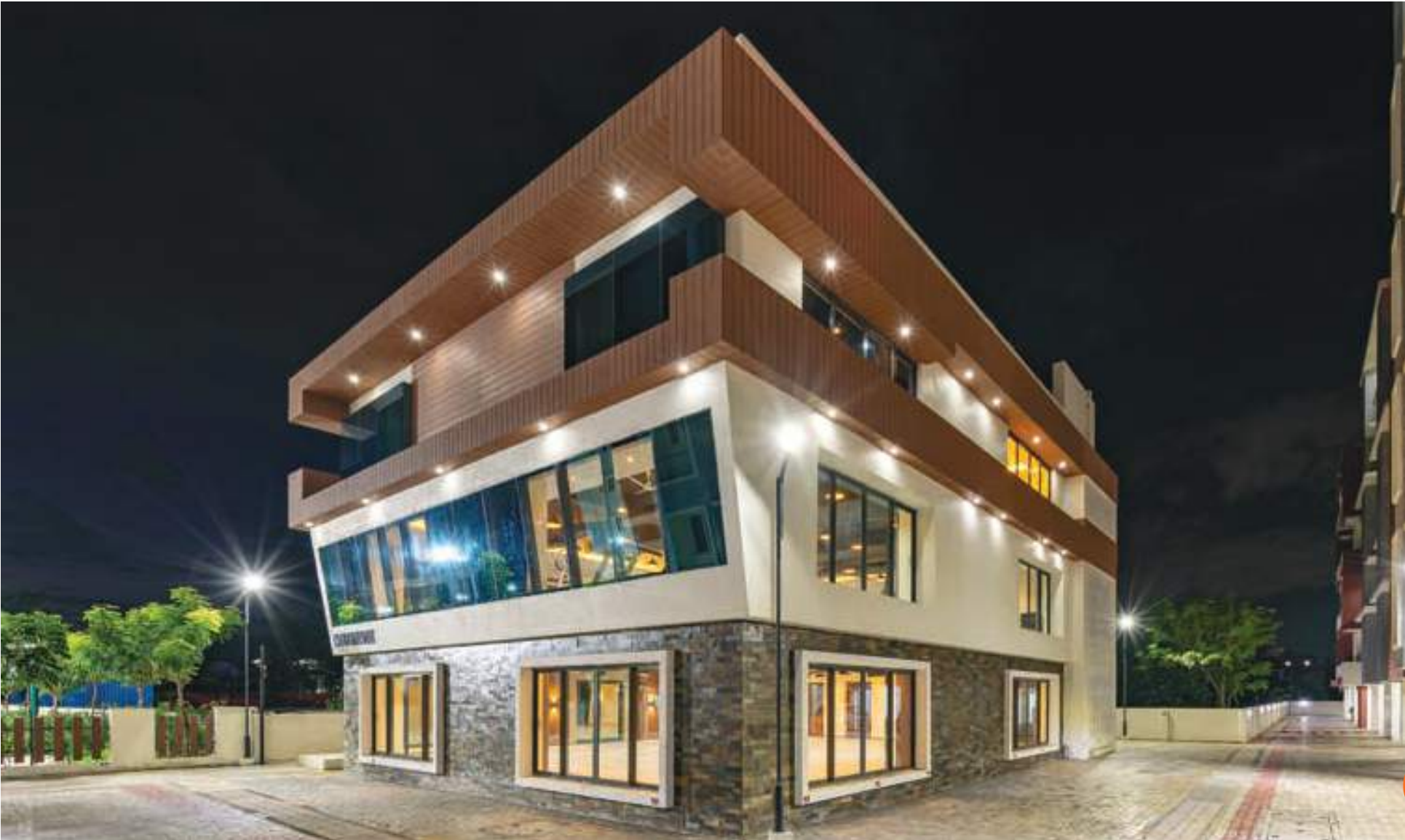
ACTUAL SITE PHOTO
